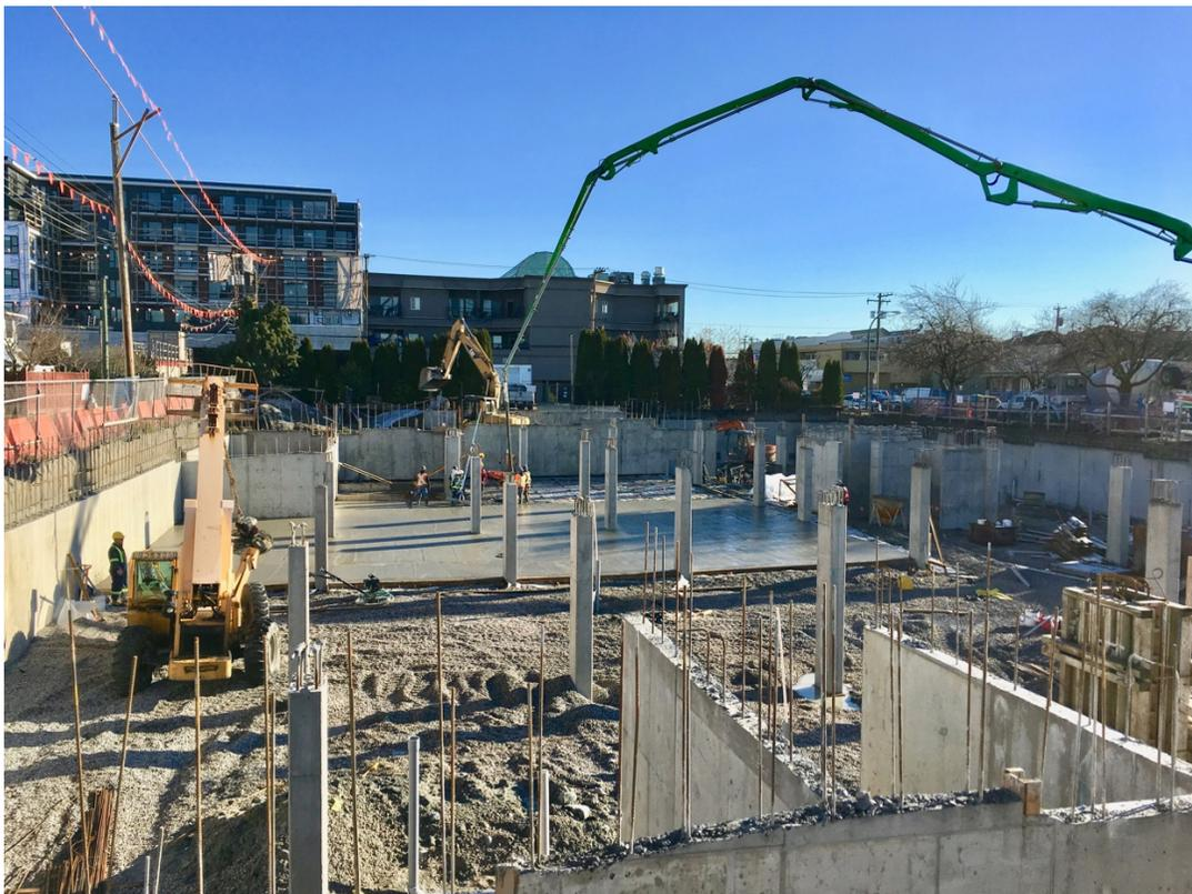
Imagen 5: Colado de concreto para losas de estacionamiento (5 de diciembre del 2018)
