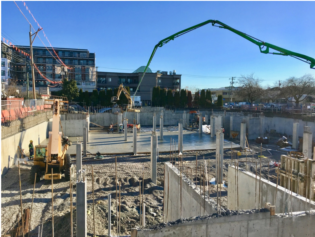
圖五、地下室樓板混凝土澆置 (2018 年 12 月 5 日)
